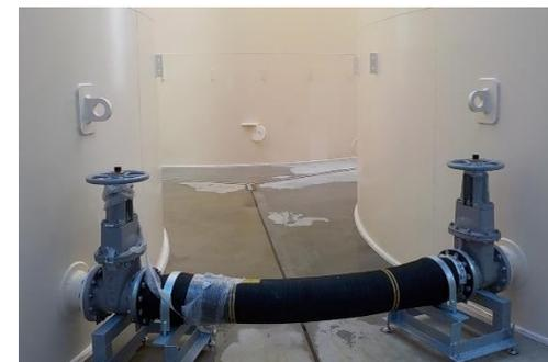
G4北・G5の連結配管 (耐圧ゴムホース) は、G1・G4南エリアで使用しているものと同等品である。(製造者仕様の範囲内で運用する)
