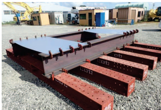
写真1 模擬屋根設置
