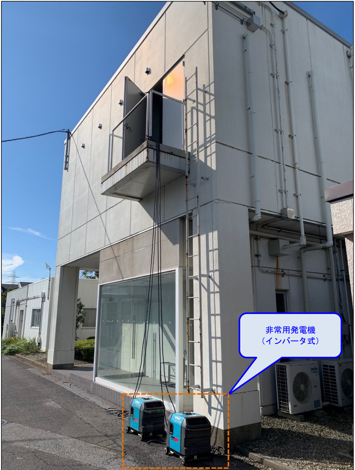
図 8 モニタリングポストデータオンライン収集システムを発電機等で運用した時の様子
