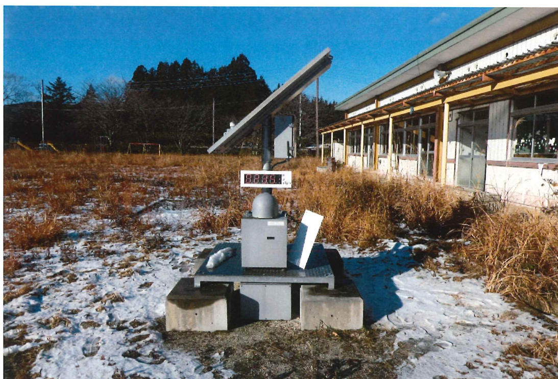
図 2-10-11(1) 撤去前のモニタリングポスト (荻野小学校 (浪江町) : 2021 年 1 月 13 日撮影)
