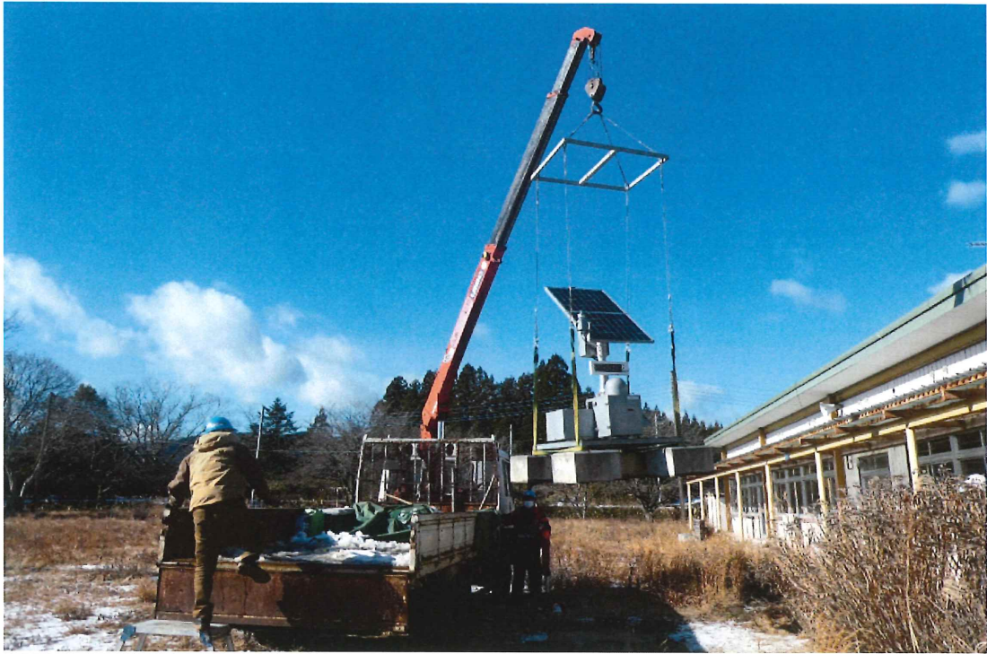
図 2-10-11(2) 撤去作業の様子 (荻野小学校 (浪江町) : 2021 年 1 月 13 日撮影)
