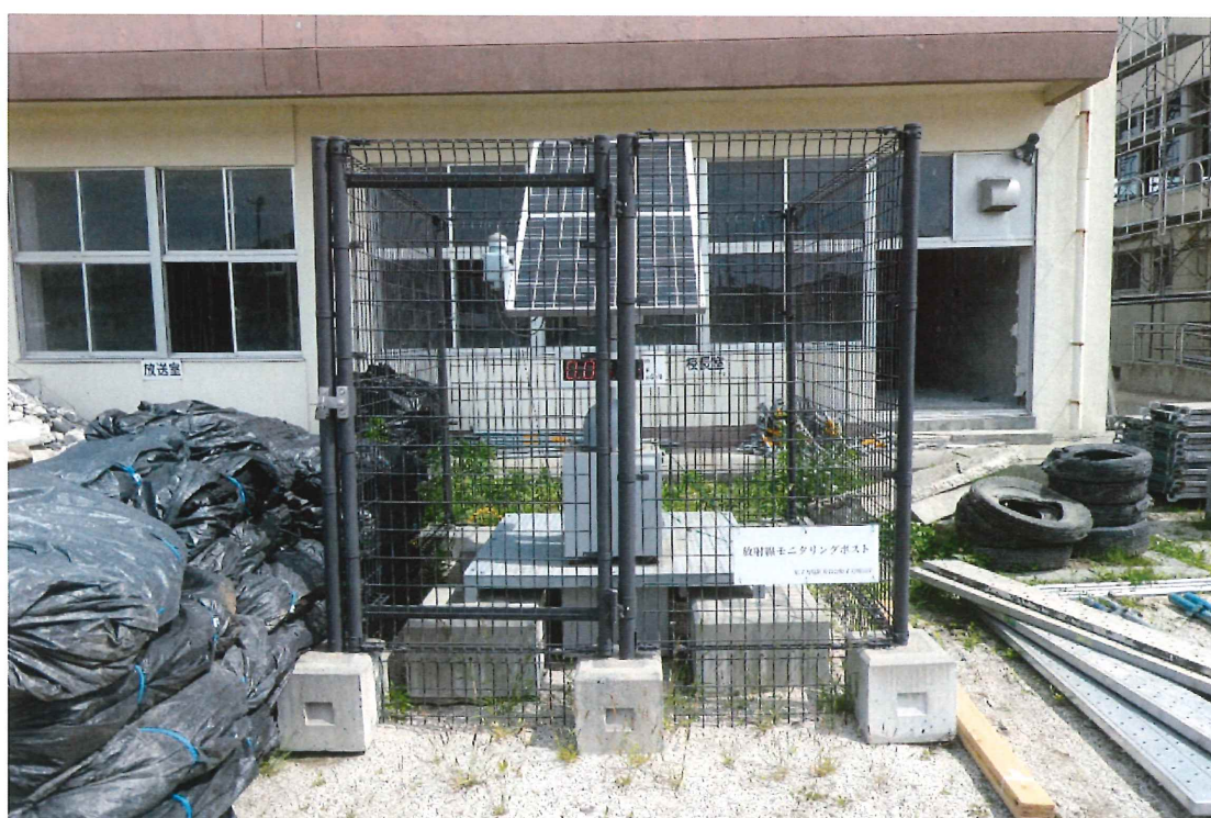
図 2-10-10(1) 撤去前のモニタリングポスト (富岡第一小学校 (富岡町) : 2020年5月28日撮影)
