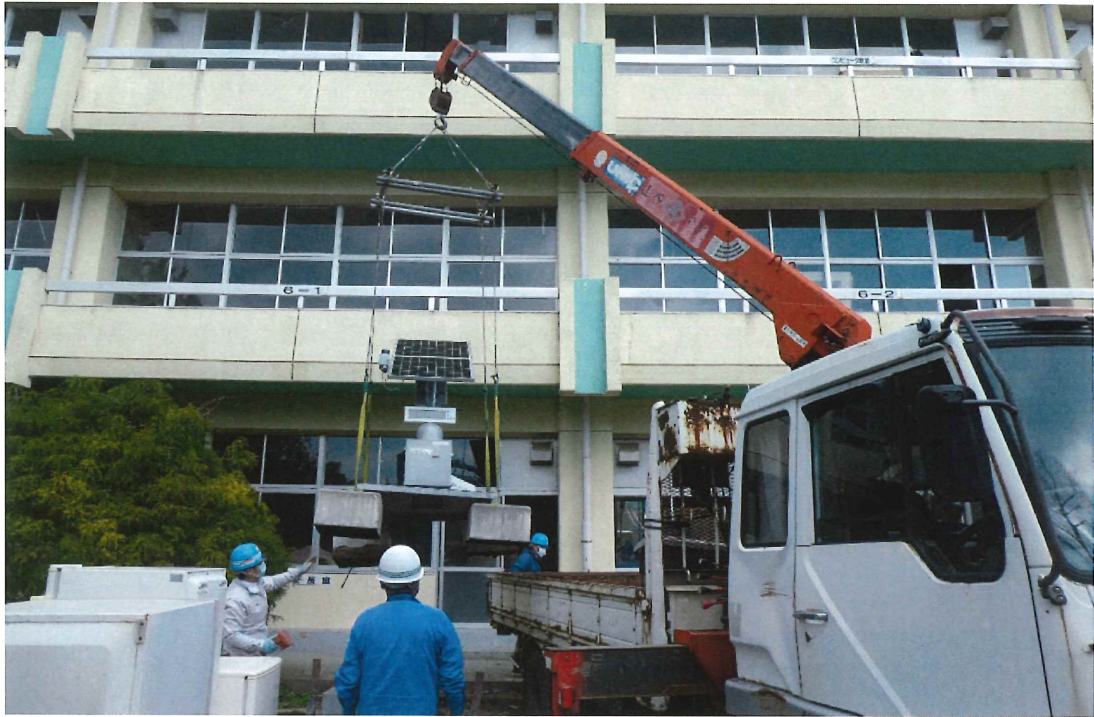
図 2-10-9(2) 移設作業の様子 (富岡第二小学校校舎南側 (富岡町) : 2020年4月28日撮影)
