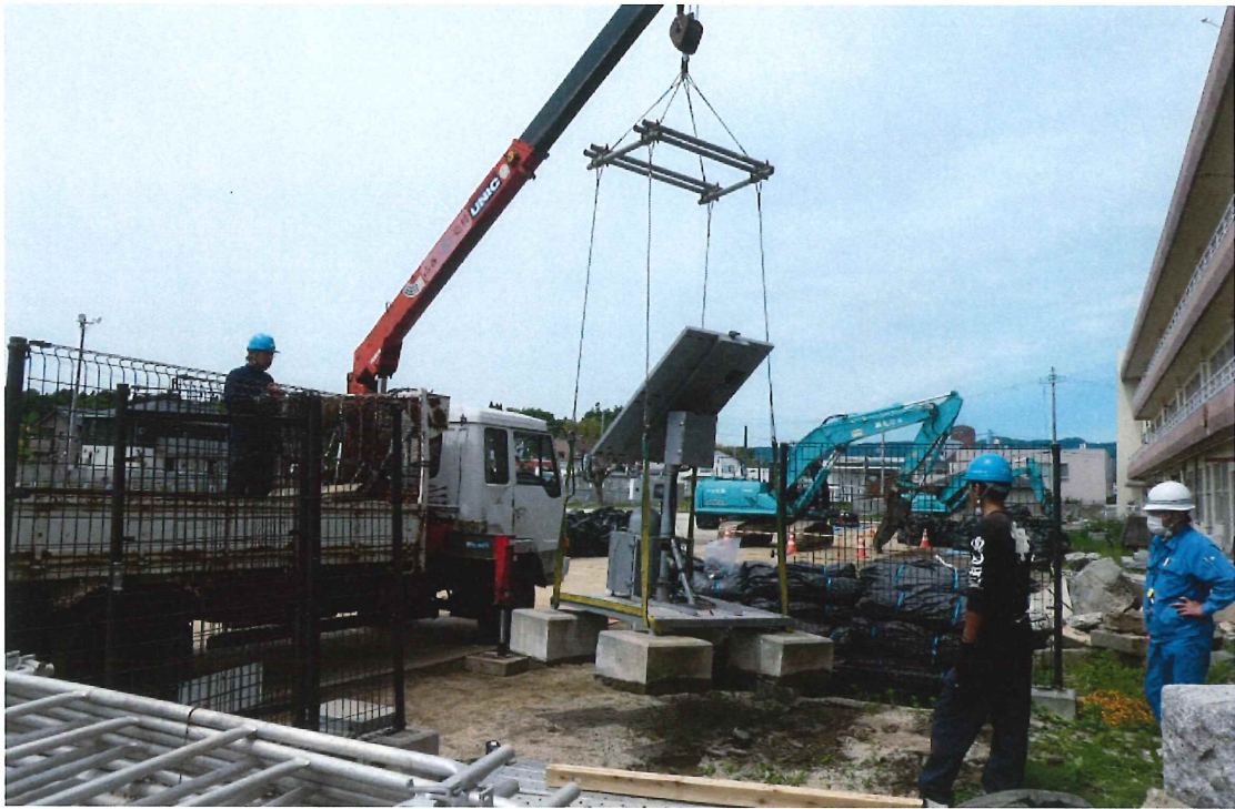
図 2-10-10(2) 撤去作業の様子 (富岡第一小学校 (富岡町) : 2020年5月28日撮影)
