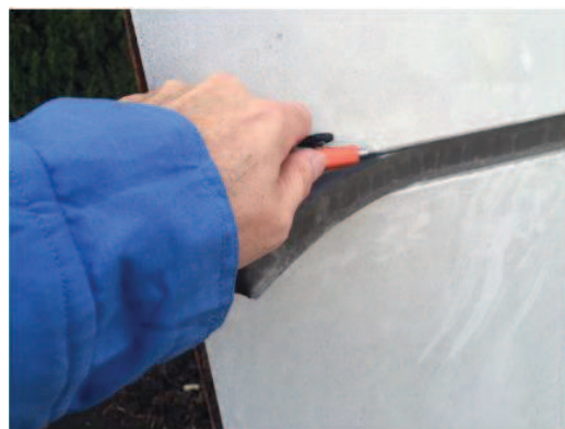
シリコーン材の切り取り状況
