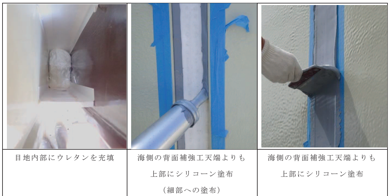
図 6.1.5-37(1) ウレタンシリコーン目地の施工状況
