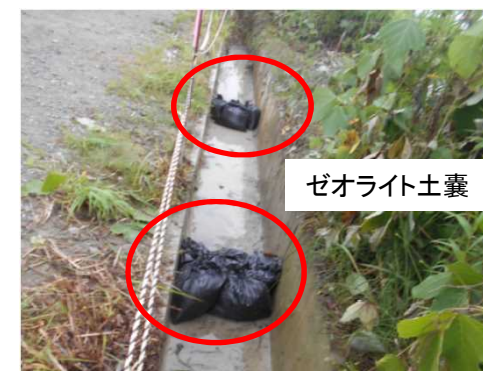
【ゼオライト土嚢設置後の東側流入地点（7/7撮影）】
