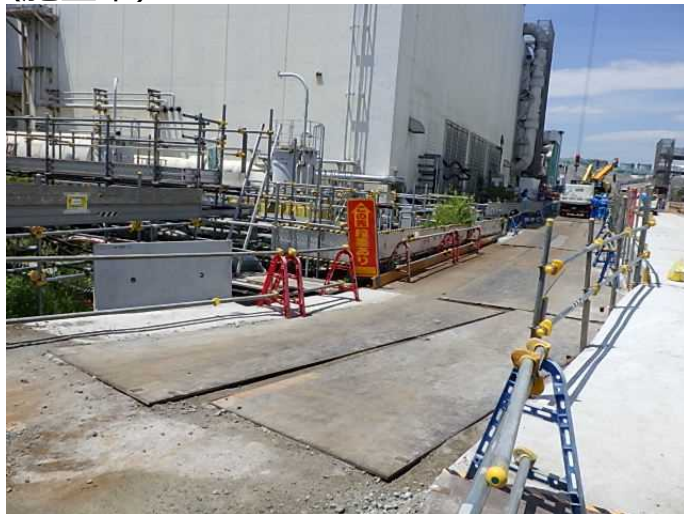
■ 2-3号間道路（海側） 状況写真 (施工中)
