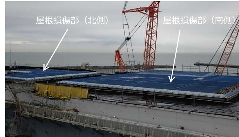
屋根状況【流入防止堰・雨水カバー設置完了】 〔西側から撮影〕
