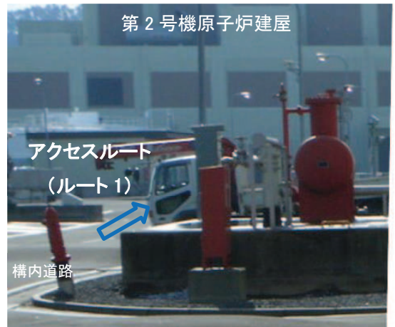
写真 C:地震後の状況【平成 23 年 3 月 12 日撮影】
