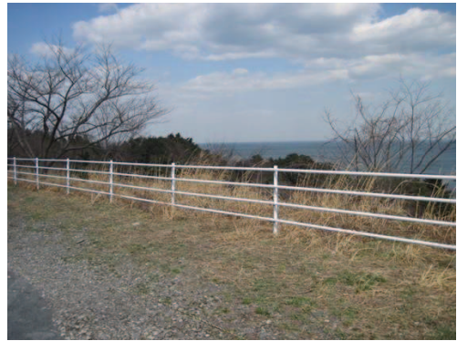
状況写真①
