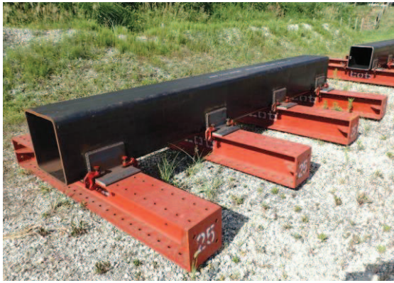
写真1 模擬建屋構造材設置
