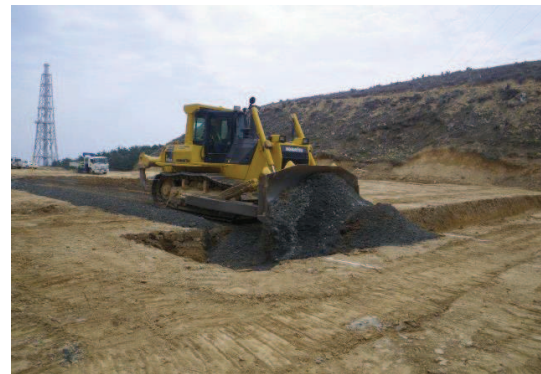
写真2 碎石運搬・埋め戻し・転圧状況
