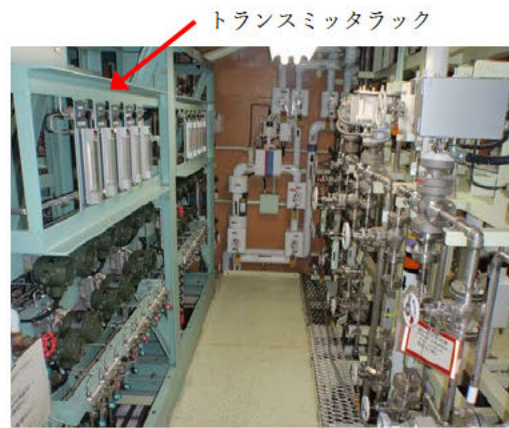
図-2 配管分岐室におけるトランスミッタラック等の設置状況
