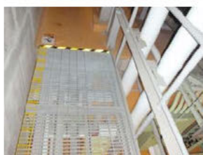
配管分岐室横のグレーチング通路
