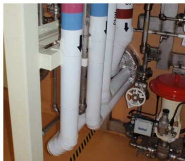
図-1 配管分岐室におけるセル貫通部の蒸気配管等の設置状況
