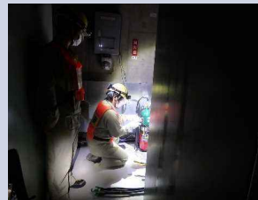
電気室内パワーセンター仮設ケーブル敷設
