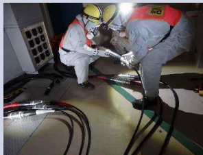
開閉所MCCケーブル接続
