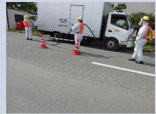
ケーブル搭載車からケーブル取出・敷設
