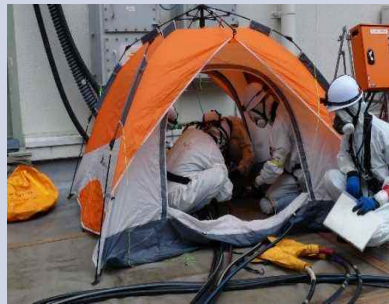
ケーブル接続(降雨対策簡易テント内)
