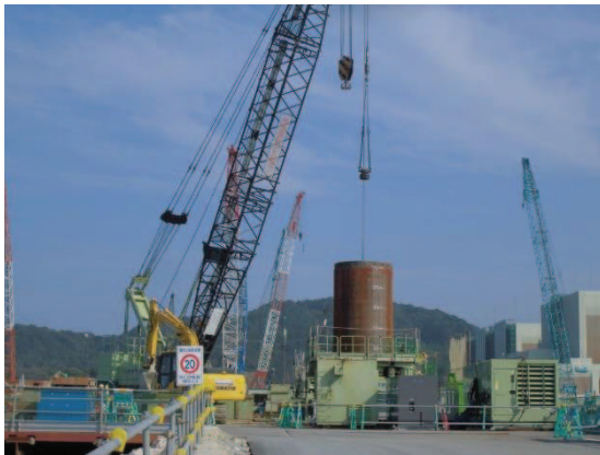
(オールケーシング工法による掘削)
