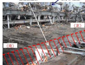
④基礎設置部 (東側、外部)
