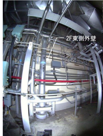
④2F東側外壁
