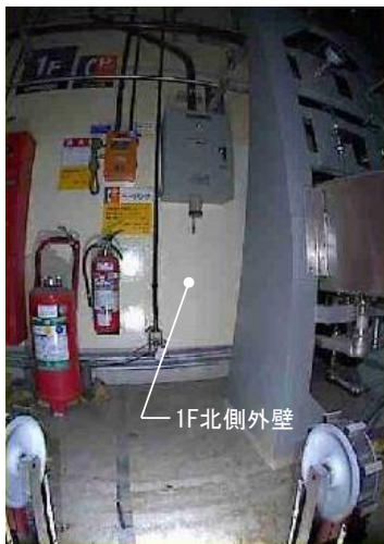
①1F北側外壁
