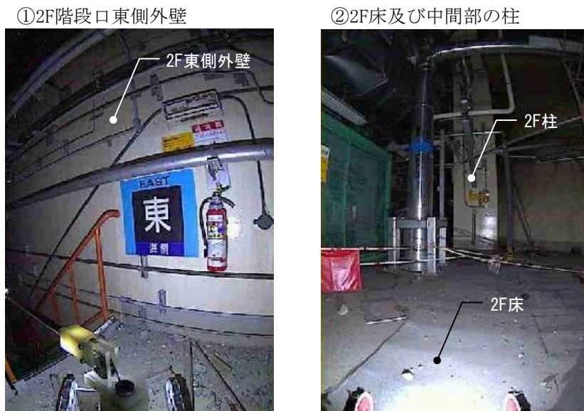
図-2.4(1) 建屋内状況写真（2階）
