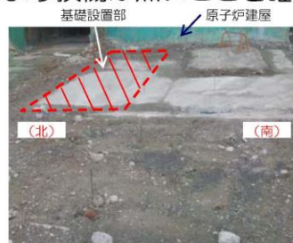
③基礎設置部 (西側)
