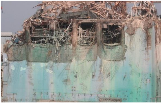
②東側壁面
