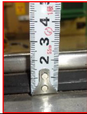
廃液処理室(IV)-1 前廊下との障壁 (高さ: 約 2.3cm) ※評価上は、保守的に 2cm とする。
