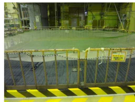
大物搬入口外観(グレーチング)
