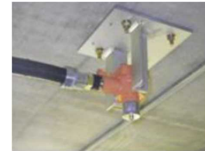
水素濃度検出器設置
