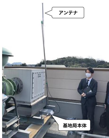
図 31 (左) 基地局の設置箇所。島根県原子力環境センター北東側には 5 階建の島根県保健環境科学研究所がある。地図画像は国土地理院地図を使用。(右) 屋上に設置された基地局とアンテナの様子。高さ 3 m にアンテナが設置されている。
