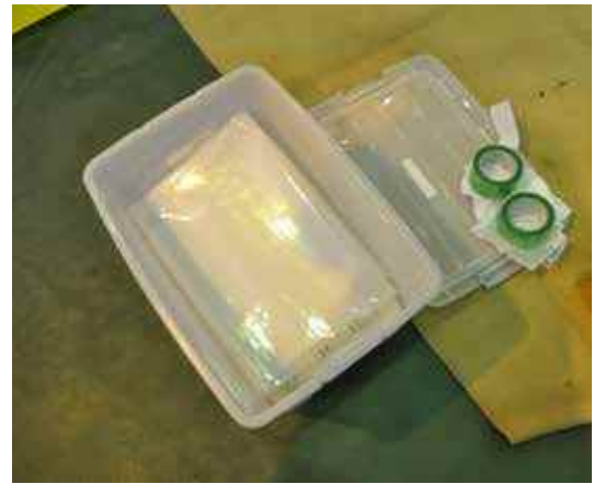
図8 養生シートの保管 切り抜いた養生シートは折りたたんで保管する。
