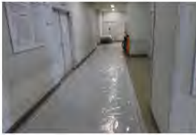
入り口から処置室までの廊下の養生
