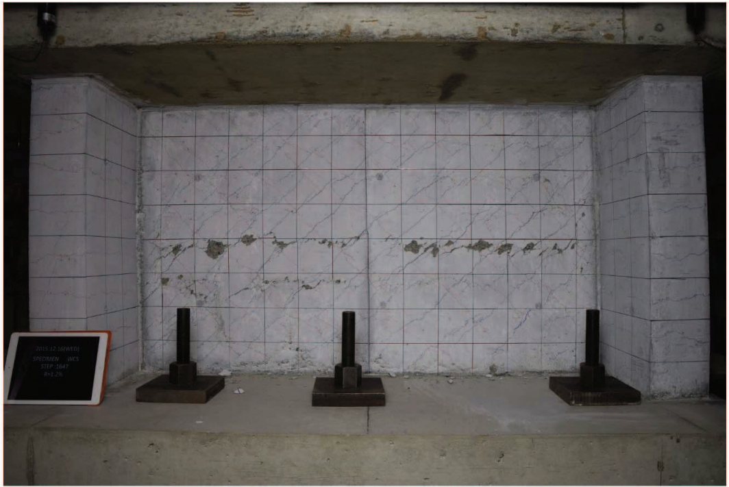
図 3-2 最終破壊時写真
