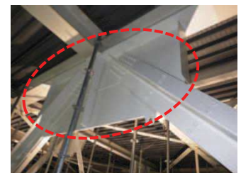
屋根トラス接合部の補強状況写真
