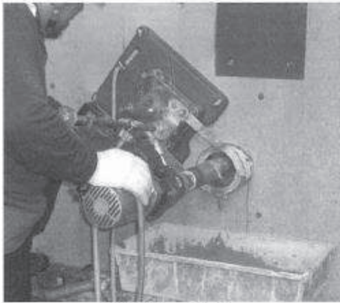
RC 部材への削孔
