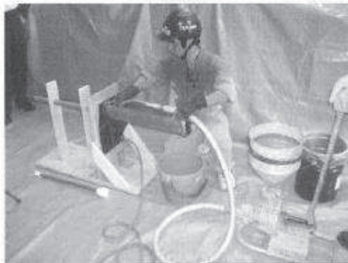
グラウトの充てん状況
