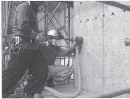
レッグハンマーによる削孔
