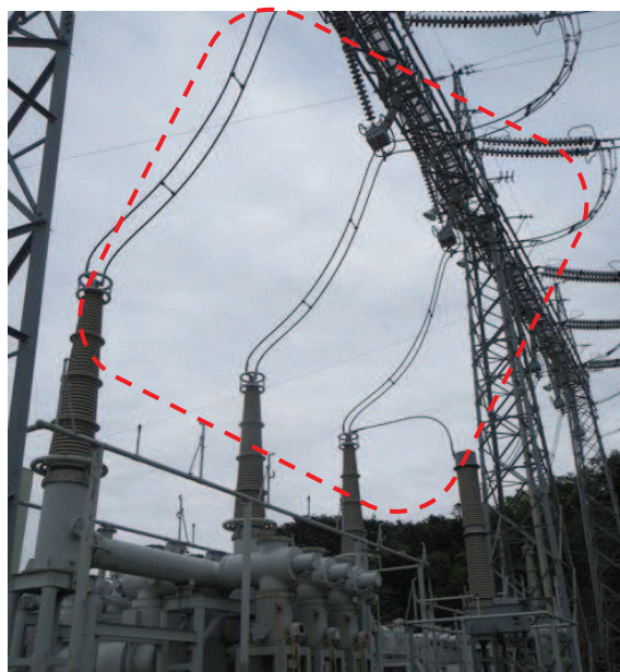
275kV 送電線引込み部（イメージ）
