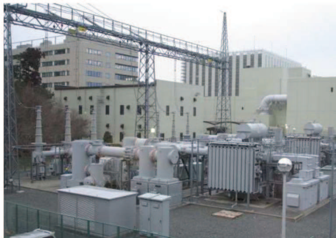
(ガス絶縁開閉装置イメージ)
