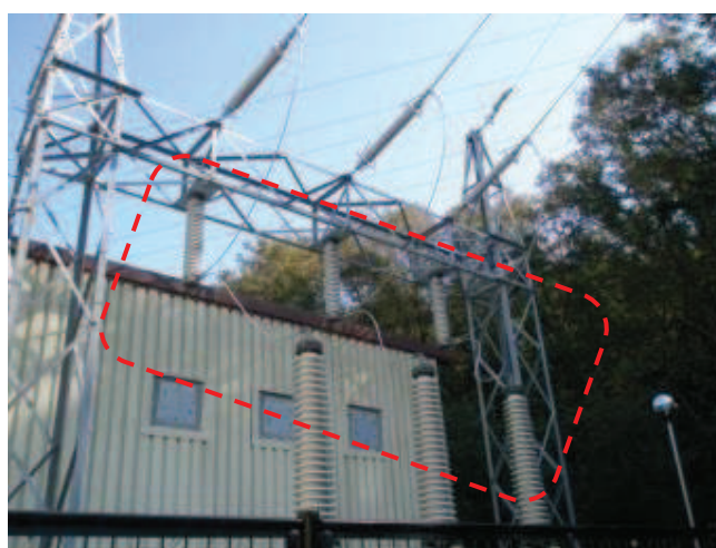
66kV 送電線引込み部（イメージ）
