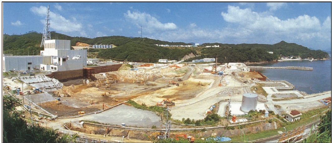
図 3-5 第 2 号機建設時の掘削状況
