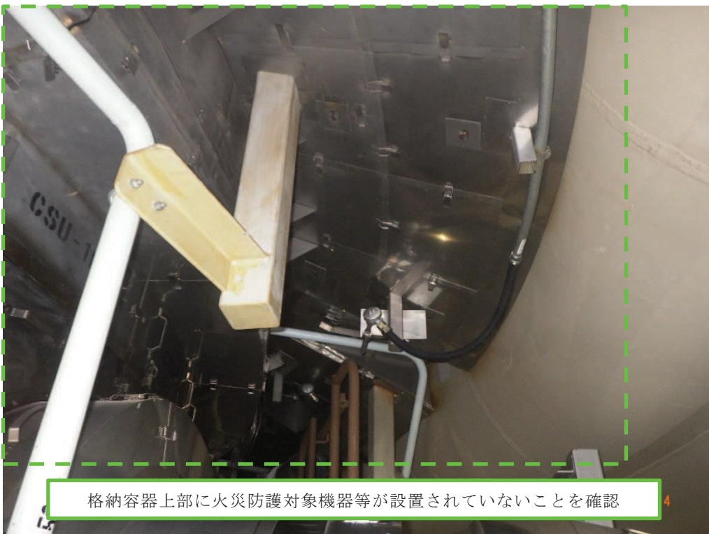
図8 原子炉格納容器上部
