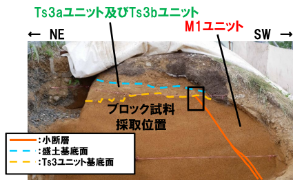
開削調査箇所(南側)南側壁面 小断層上端付近 拡大写真
