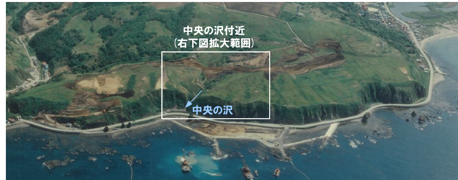
敷地の斜め空中写真 (1983年夏頃当社撮影)
