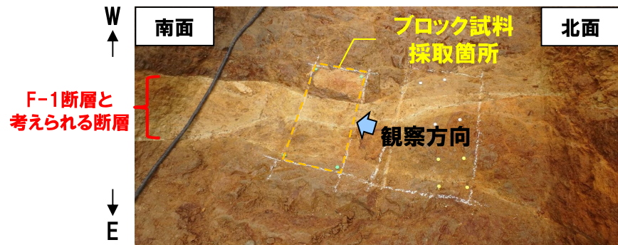
底盤写真(近景)
