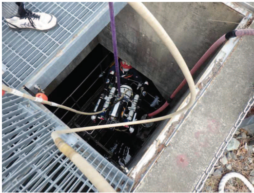
水中カメラを放水路内に投入
