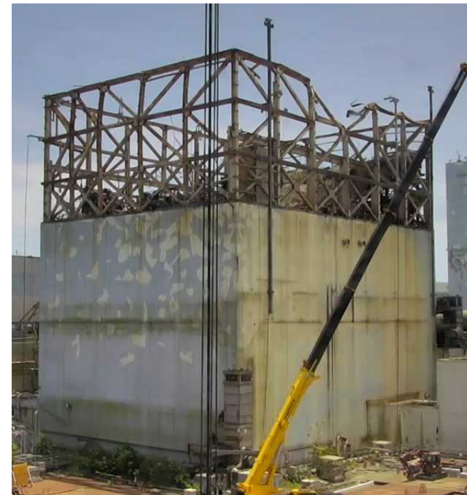
1号機原子炉建屋全景（2021年6月3日時点）
