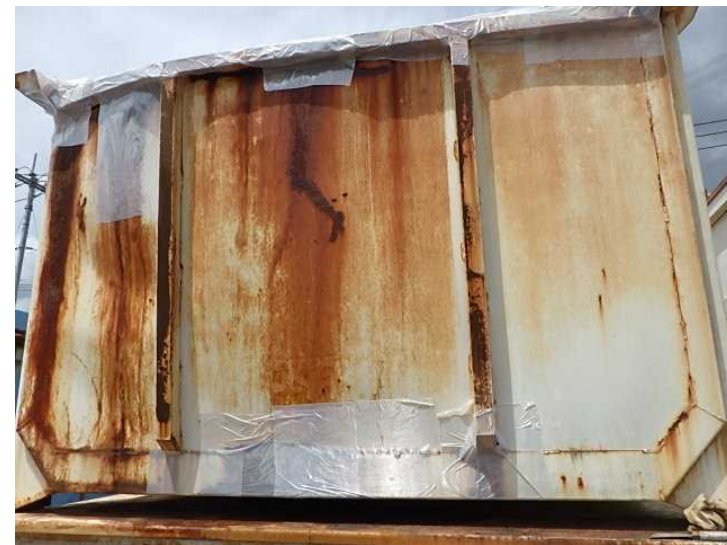
フィラメントテープによる養生後
