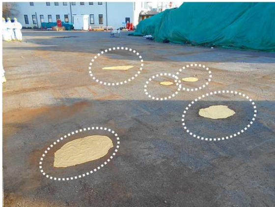
堆積物除去・除染材塗布後（3月24日）
