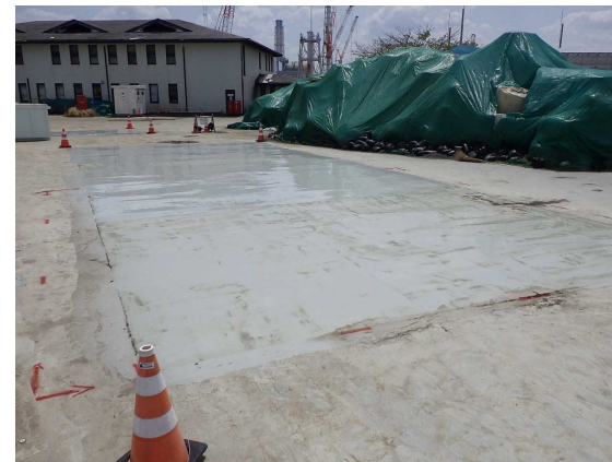
アスファルト再舗装(4月15日)・塗装(4月16,19日) 【4/20撮影】
