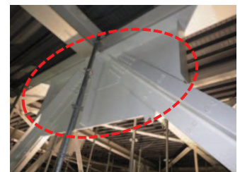
屋根トラス接合部の補強状況写真
