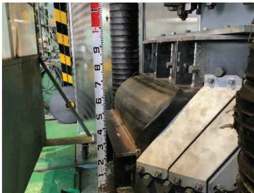
加圧状況 (漏えい無し)
