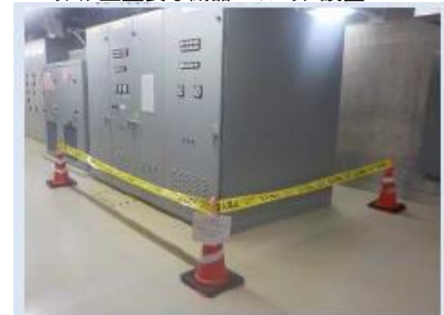
リスク上重要な機器へのバリア設置
