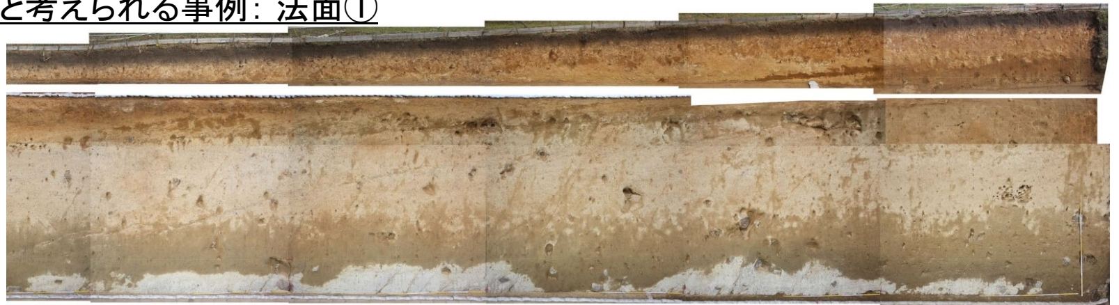
法面① 写真
