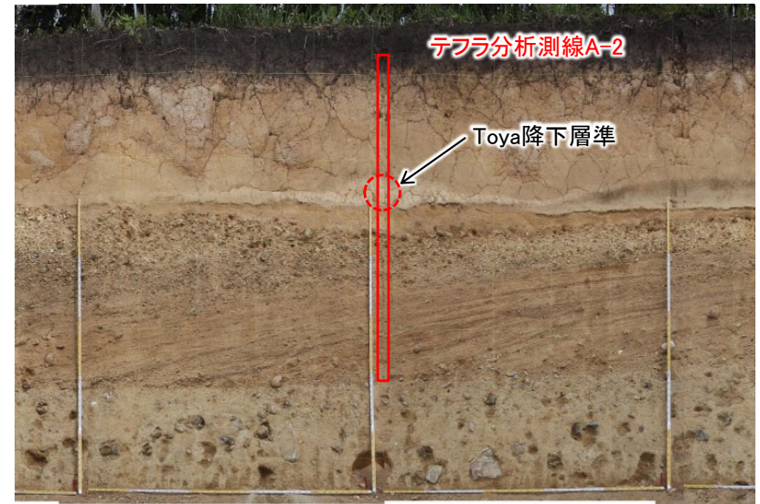
法面④詳細画像
