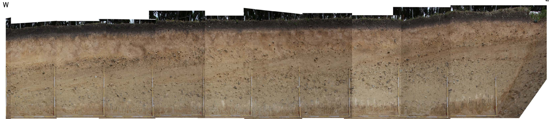
法面③ 写真
