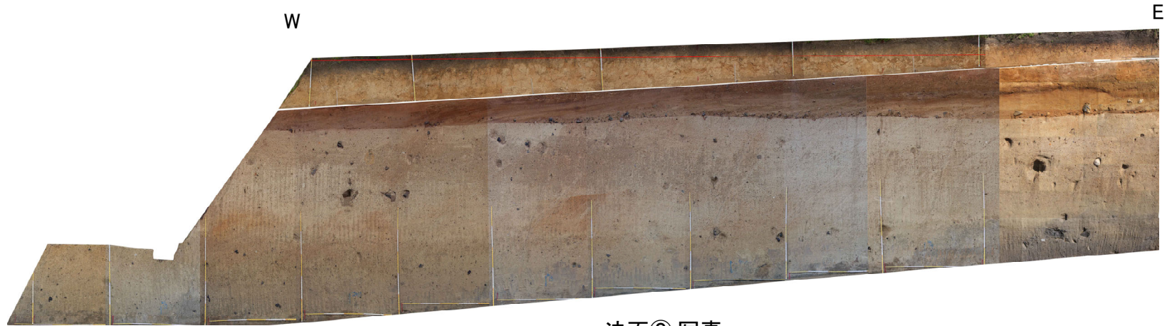
法面② 写真
