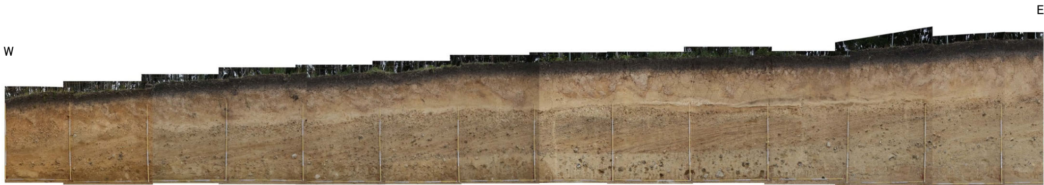
法面④ 写真
