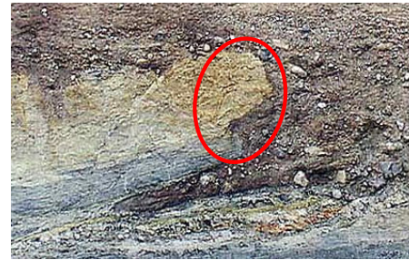
⑦ 9.5m西方法面
