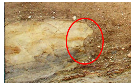
⑩ 14m西方法面
