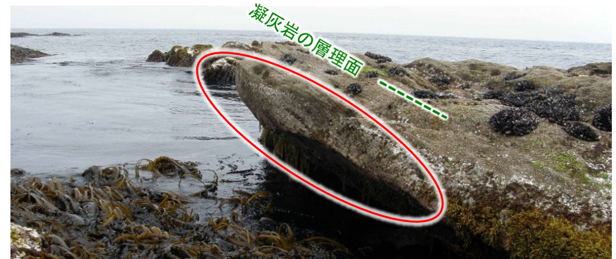
下北半島ちぢり浜の海岸侵食の事例
