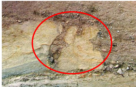
⑤ 6.5m西方法面
