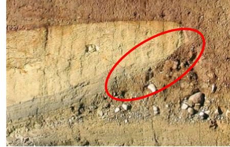
③ 3.5m西方法面
