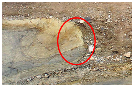
⑨ 12.5m西方法面
