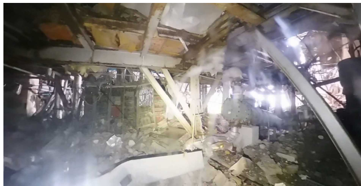
【3号機原子炉建屋 4階】
