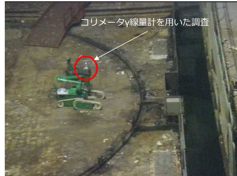
測定点⑩における天井面測定状況
