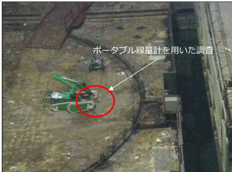
測定点⑩における床面測定状況
