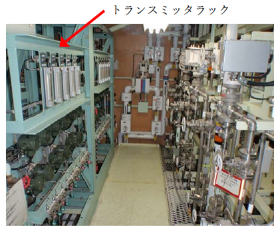
図-2 配管分岐室におけるトランスミッタラック等の設置状況
