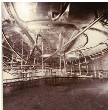
高放射性廃液貯槽(V36)下部
