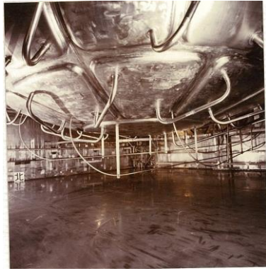
高放射性廃液貯槽 (V33) 下部
