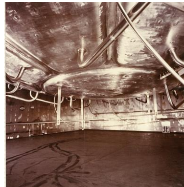
高放射性廃液貯槽(V32) 下部
