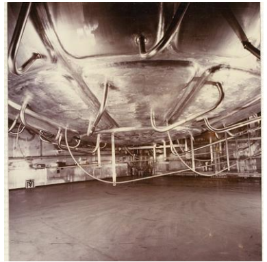
高放射性廃液貯槽 (V35) 下部
