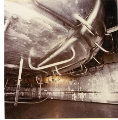
高放射性廃液貯槽（V31）下部
