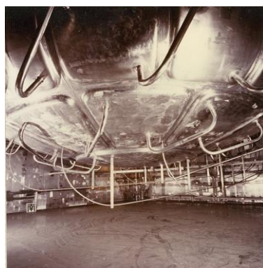
高放射性廃液貯槽(V34) 下部
