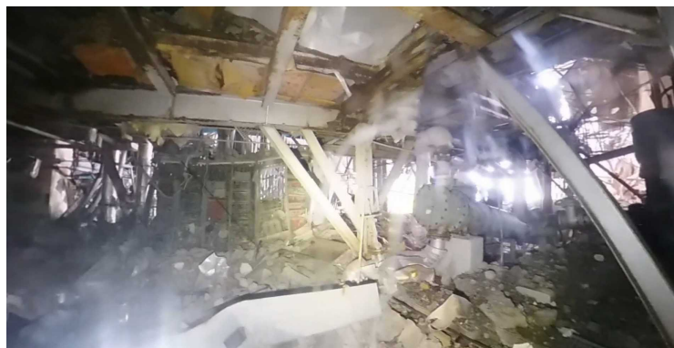
【3号機原子炉建屋 4階】
