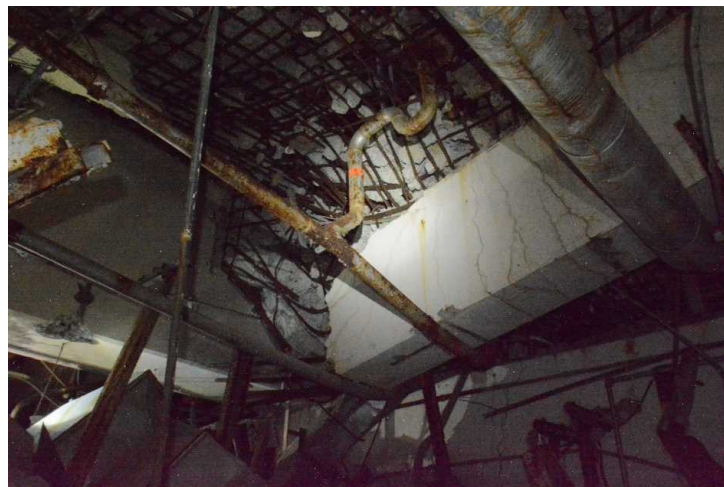
【3号機原子炉建屋 3階】
