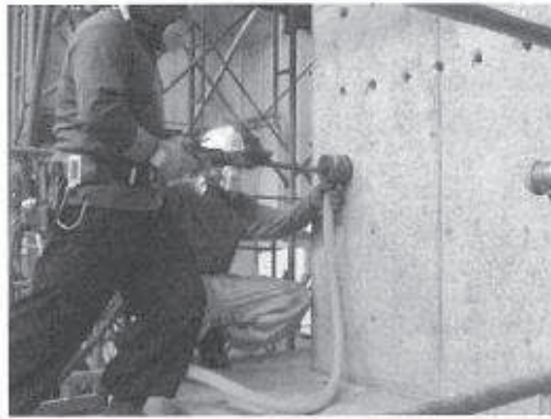
レッグハンマーによる削孔
