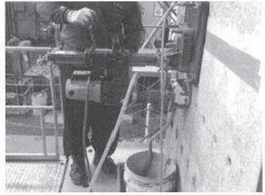
コンクリートコアドリルによる拡張削孔
