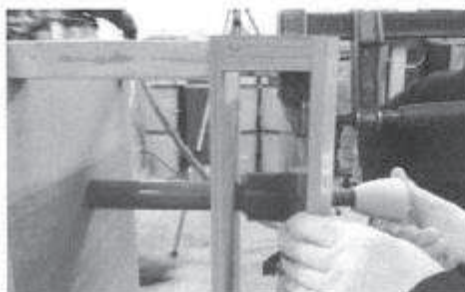
「セラミックキャップバー (CCb)」の挿入
