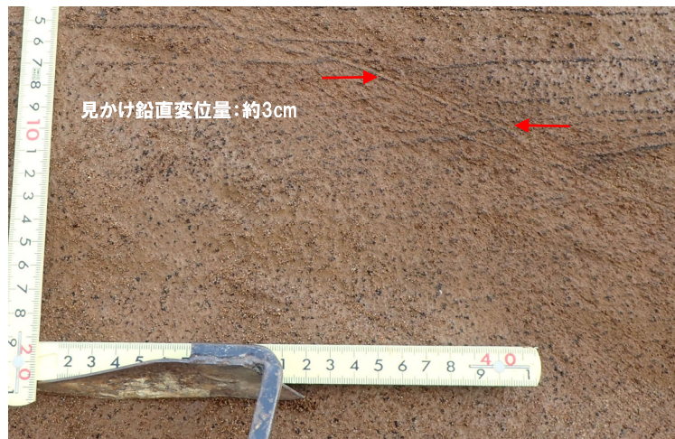
①-1 見かけ鉛直変位量計測箇所
