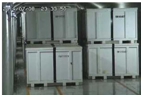
固体廃棄物貯蔵庫
