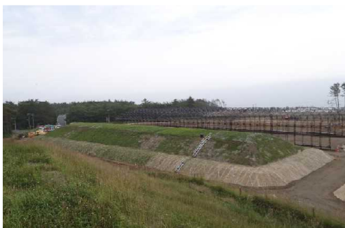
覆土式一時保管施設
