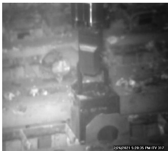
3号機での燃料の吊り上げ（566体目）
