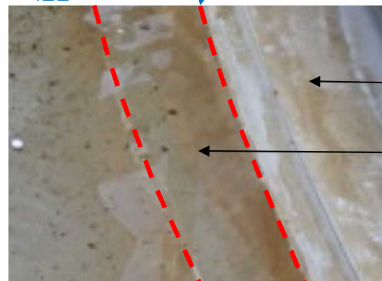
基礎コンクリート面 (ポリウレタ剥れ)
