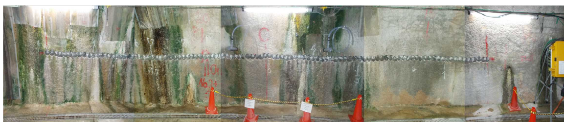
図 2.1.13 300 m アクセス研究坑道における調査ポイント状況写真
